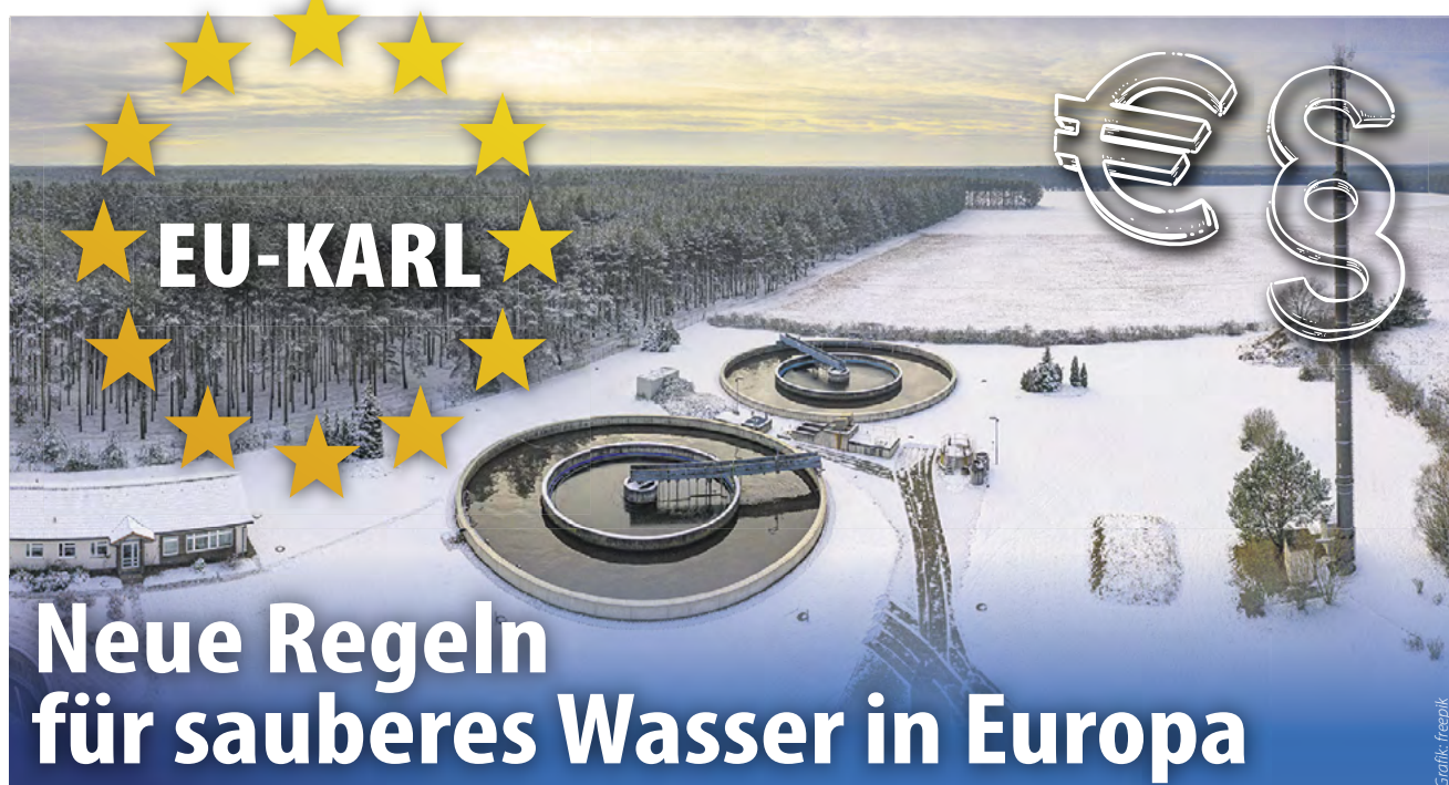
Mit der EU-Richtlinie „KARL“ sollen Kläranlagen künftig noch besser arbeiten für mehr Umwelt- und Gewässerschutz.
