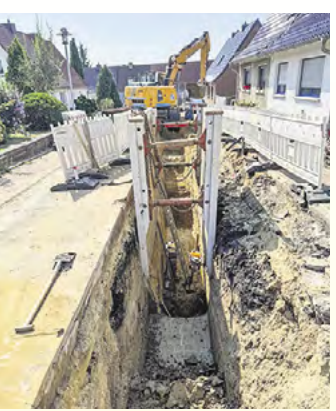
12 Schachtbauwerke wurden im Dammühlenweg gesetzt.
